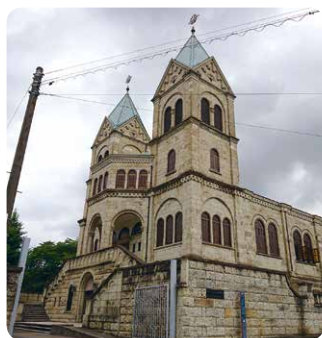
●カトリック松が峰教会 礼拝堂の屋根と2階の床を焼失した。 礼拝堂の壁に焼け跡が残る。
